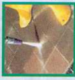
Bodenreinigung mit Heißwasserhochdruck
