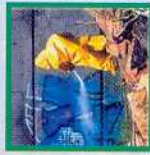
Graffiti-entfernung mit Heißwasserhochdruck
